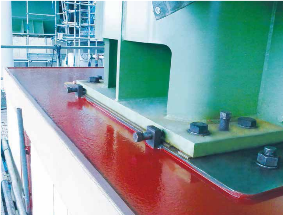
Motor supported on deep pour Chockfast®
